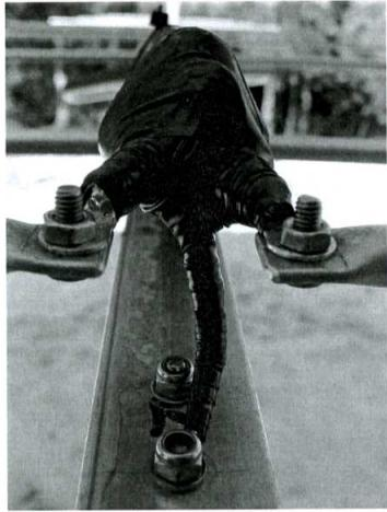
2 metrin antennin syöttöpiste impedanssimuuntajineen.
